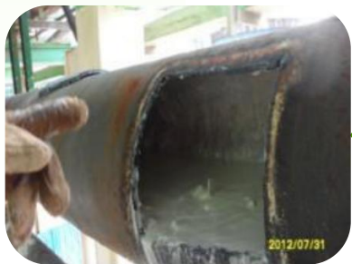
磁化器下游 100 米 没有任何结垢
