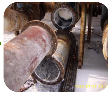
剩磁性杂质及垢灰，灰组织质地松散，用水冲即可，还形成氧化三铁保护层
