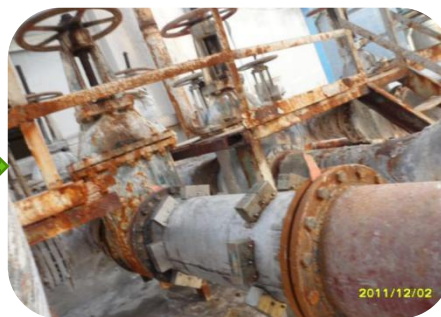
25mm垢海绵状，截管改6mm壁厚管，安装14个磁化器
