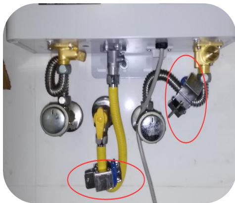
磁化器安装至热水器外
