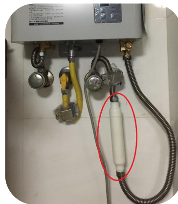
磁化管安装至热水器外
